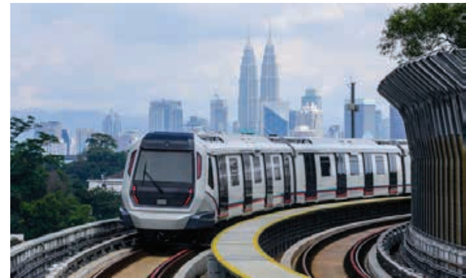
Tuyến metro MRT Kajang Line tự động không người lái do Gamuda Berhad phát triển tại Malaysia
