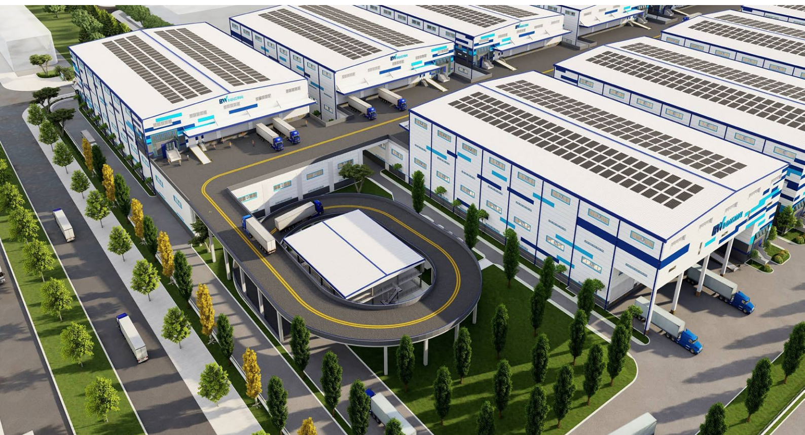
Là thủ phủ công nghiệp”, Bình Dương là nơi tập trung lượng lớn lao động, kỹ sư, chuyên gia trong và ngoài nước, tạo ra nhu cầu nhà ở tăng cao. Ảnh: Khu công nghiệp VSIP
